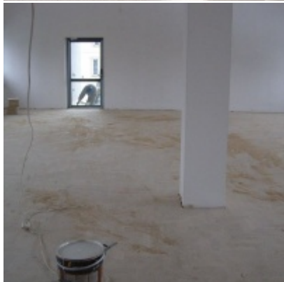
Modernizacja OSP w Zatorze
