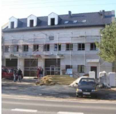
Modernizacja OSP w Zatorze
