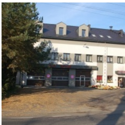
Modernizacja OSP w Zatorze
