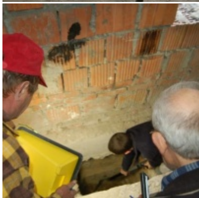
Rozbudowa i remont budynków Urzędu Miejskiego 2008/2010
