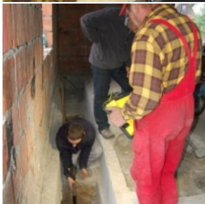
Rozbudowa i remont budynków Urzędu Miejskiego 2008/2010
