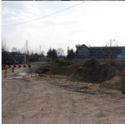
Kompleksowa modernizacja ciągu komunikacyjnego - ul. J. Słowackiego
