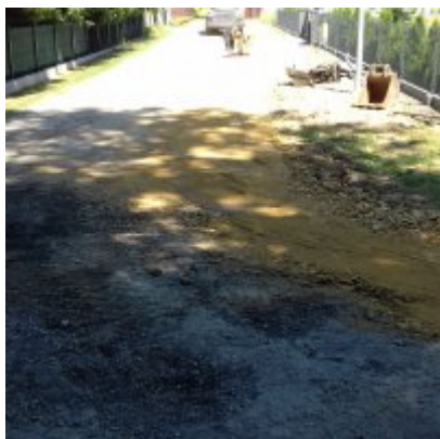
Rozpoczęto prace modernizacyjne na ul. Grunwaldzkiej
