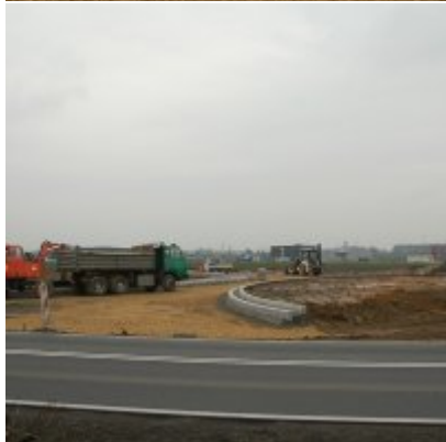
2016-04-13 Bieżący stan prac przy budowie ronda
