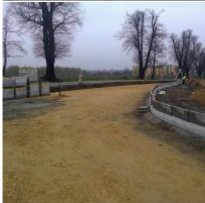
2016-04-13 Bieżący stan prac przy budowie ronda
