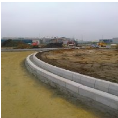
2016-04-13 Bieżący stan prac przy budowie ronda
