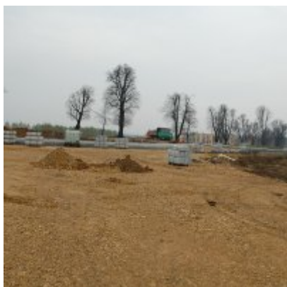
2016-04-13 Bieżący stan prac przy budowie ronda
