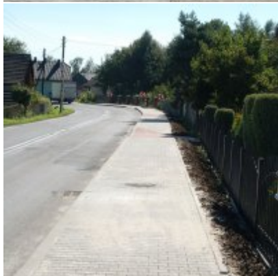
Wyremontowany chodnik w Podolszu
