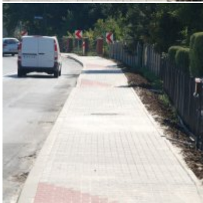
Wyremontowany chodnik w Podolszu
