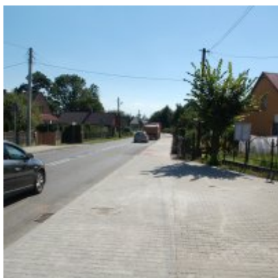
Wyremontowany chodnik w Podolszu
