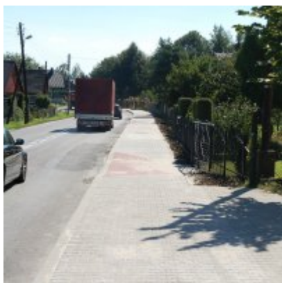
Wyremontowany chodnik w Podolszu
