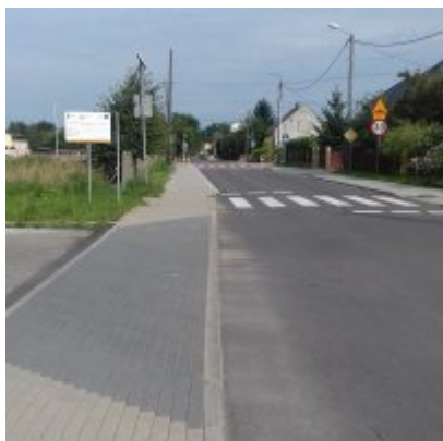
Przebudowa drogi gminnej - odcinek ul. Jana Pawła II w Zatorze
