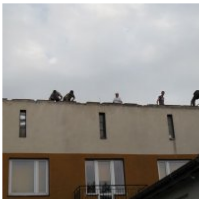
Remont dachu w ZSO Podolsze
