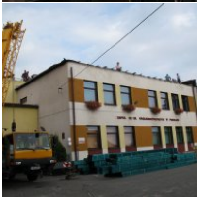
Remont dachu w ZSO Podolsze
