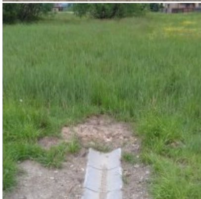
Rozpoczęcie robót dróg
