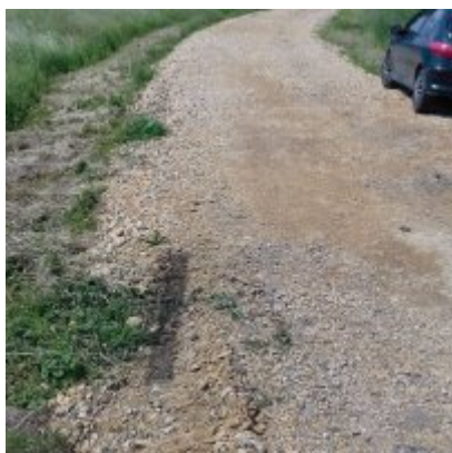
Rozpoczęcie robót dróg
