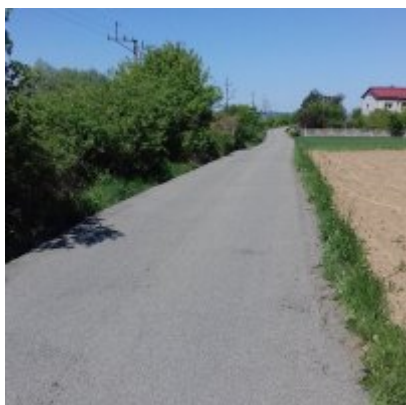
Rozpoczęcie robót remontowych
