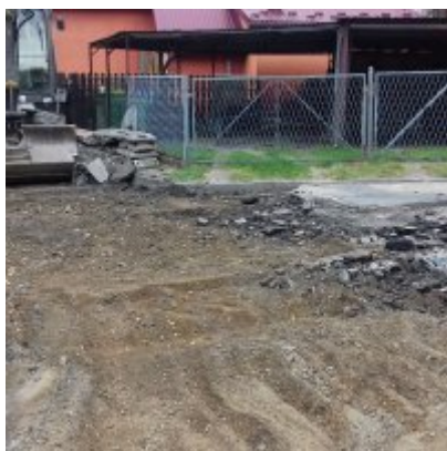
Remont ulicy Szkolnej w Zatorze
