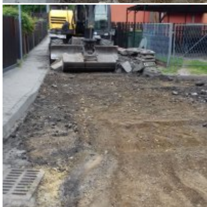
Remont ulicy Szkolnej w Zatorze
