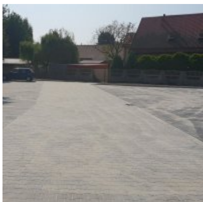
Budowa miejsc postojowych dla samochodów w Zatorze
