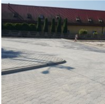
Budowa miejsc postojowych dla samochodów w Zatorze
