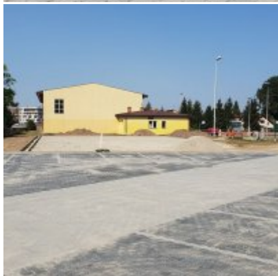
Budowa miejsc postojowych dla samochodów w Zatorze
