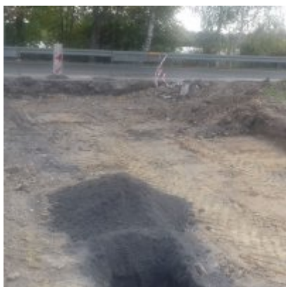
Prace budowlane na Al. Chopina w Zatorze
