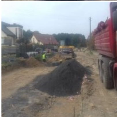
Prace budowlane na Al. Chopina w Zatorze
