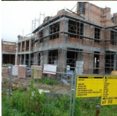
Budowa "Centrum Aktywizacji Zawodowej"
