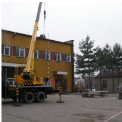
Przebudowa i modernizacja remizy strażackiej w Zatorze
