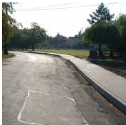
Budowa prawostronnego chodnika wzdłuż drogi gminnej - ul. E. Orzeszkowej
