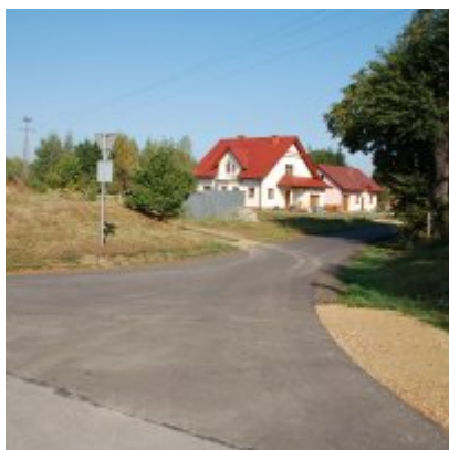
2. Przebudowa ul. Jagodowej w Podolszu
