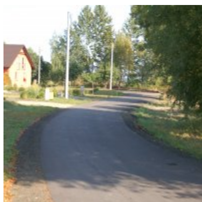
2. Przebudowa ul. Jagodowej w Podolszu
