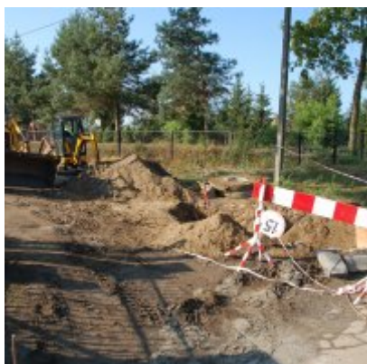
Budowa odwodnienia ul. Gimnazjalnej w Podolszu
