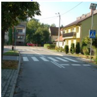
Budowa i przebudowa fragmentów lewostronnego i prawostronnego chodnika wzdłuż ul. Piastowskiej w Zatorze
