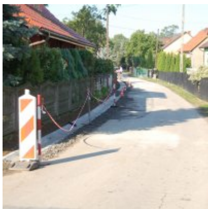
Budowa odwodnienia ul. Gimnazjalnej w Podolszu
