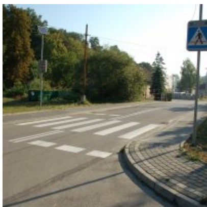
Budowa i przebudowa fragmentów lewostronnego i prawostronnego chodnika wzdłuż ul. Piastowskiej w Zatorze
