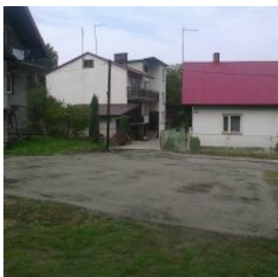
II etap modernizacji ul. Młyńskiej w Zatorze
