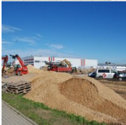
Fotogaleria Zatorskiej Strefy Aktywności Gospodarczej
