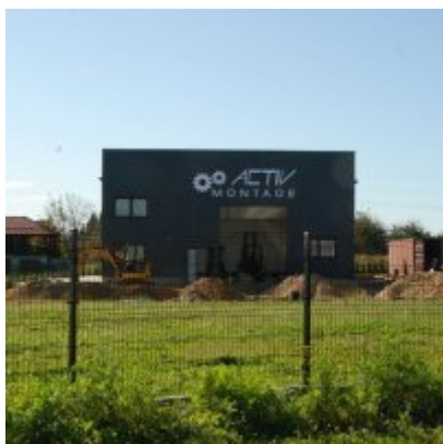
Fotogaleria Zatorskiej Strefy Aktywności Gospodarczej
