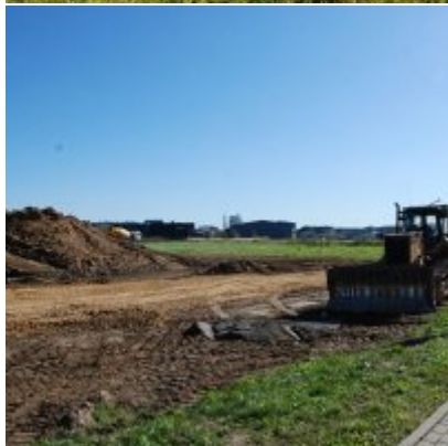
Fotogaleria Zatorskiej Strefy Aktywności Gospodarczej
