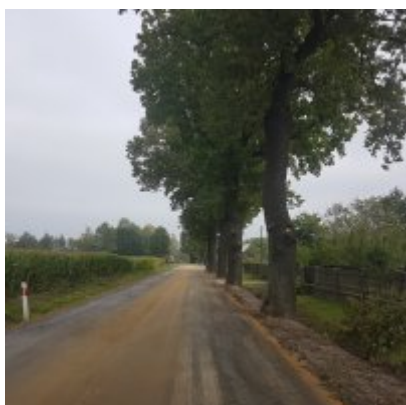
Praca wre - modernizacja drogi wojewódzkiej.
