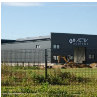
Fotogaleria Zatorskiej Strefy Aktywności Gospodarczej
