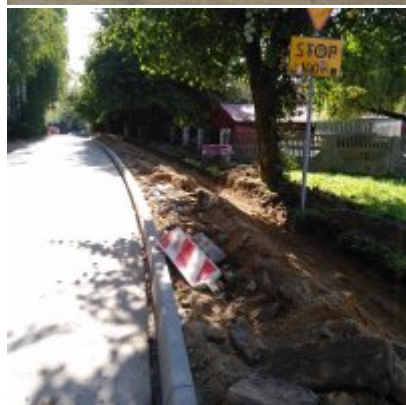
Remont chodnika - ul. Kongresowa w Zatorze
