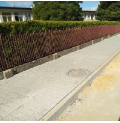
Remont chodnika - ul. Kongresowa w Zatorze
