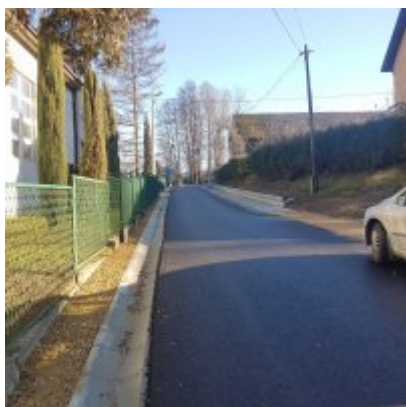
Zakończono przebudowę drogi gminnej – ul. Grabskiego
