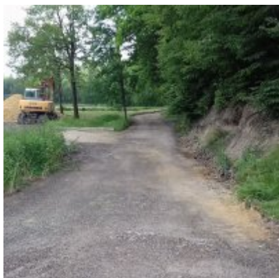
Modernizacja drogi wewnętrznej
