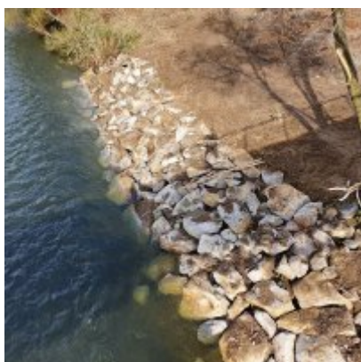
Zabezpieczenie brzegu odcinków Skawy w Gminie Zator
