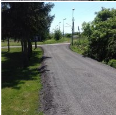
Rozpoczęcie robót remontowych
