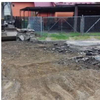
Remont ulicy Szkolnej w Zatorze
