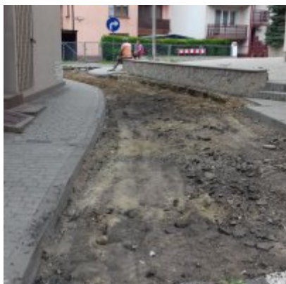
Remont ulicy Szkolnej w Zatorze
