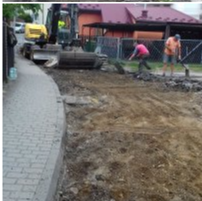
Remont ulicy Szkolnej w Zatorze
