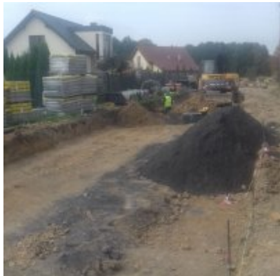
Prace budowlane na Al. Chopina w Zatorze
