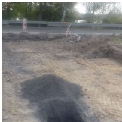
Prace budowlane na Al. Chopina w Zatorze
