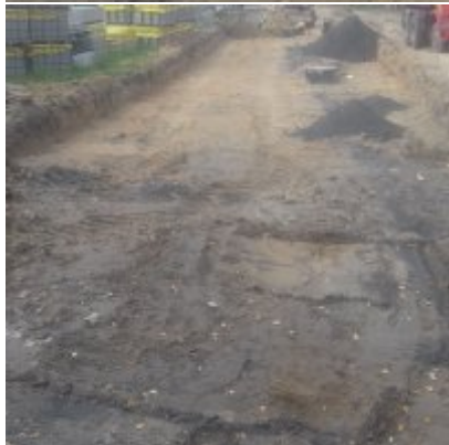
Prace budowlane na Al. Chopina w Zatorze
