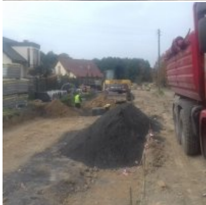
Prace budowlane na Al. Chopina w Zatorze
