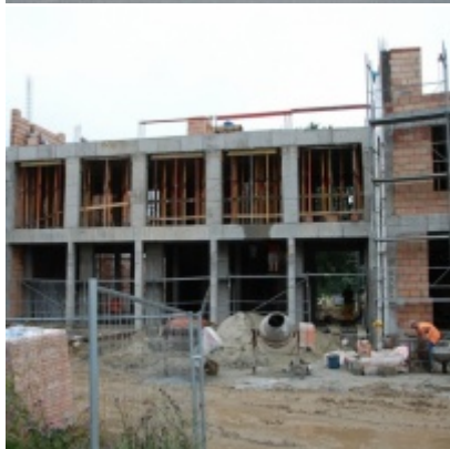
Budowa "Centrum Aktywizacji Zawodowej"
