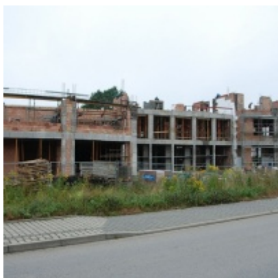
Budowa "Centrum Aktywizacji Zawodowej"
