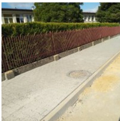
Remont chodnika - ul. Kongresowa w Zatorze
