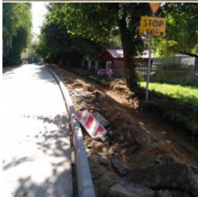
Remont chodnika - ul. Kongresowa w Zatorze
