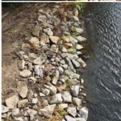
Zabezpieczenie brzegu odcinków Skawy w Gminie Zator
