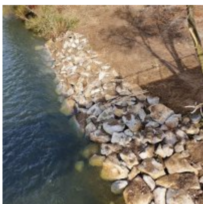
Zabezpieczenie brzegu odcinków Skawy w Gminie Zator
