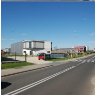
Fotogaleria Zatorskiej Strefy Aktywności Gospodarczej
