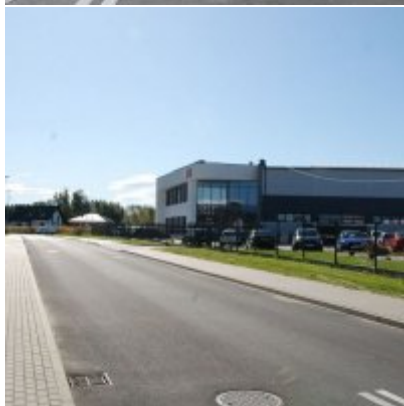
Fotogaleria Zatorskiej Strefy Aktywności Gospodarczej
