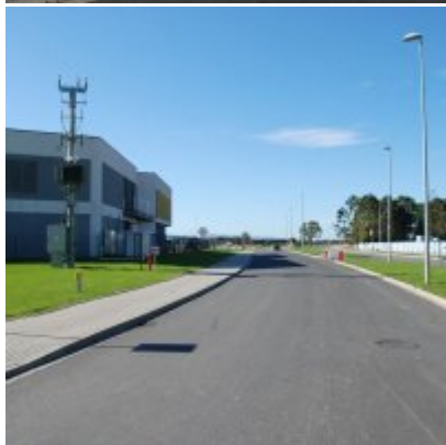
Fotogaleria Zatorskiej Strefy Aktywności Gospodarczej
