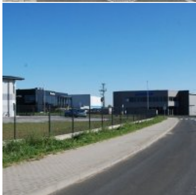
Fotogaleria Zatorskiej Strefy Aktywności Gospodarczej
