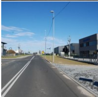
Fotogaleria Zatorskiej Strefy Aktywności Gospodarczej
