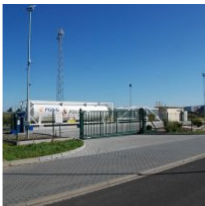
Fotogaleria Zatorskiej Strefy Aktywności Gospodarczej
