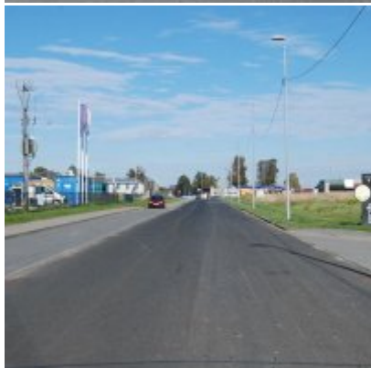
Fotogaleria Zatorskiej Strefy Aktywności Gospodarczej
