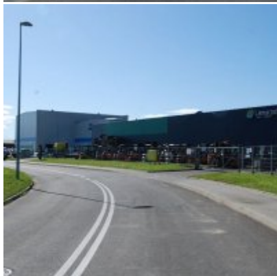
Fotogaleria Zatorskiej Strefy Aktywności Gospodarczej
