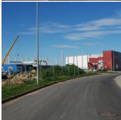
Fotogaleria Zatorskiej Strefy Aktywności Gospodarczej
