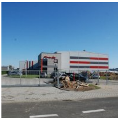
Fotogaleria Zatorskiej Strefy Aktywności Gospodarczej
