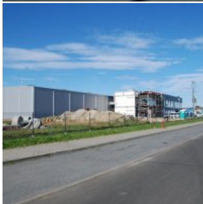
Fotogaleria Zatorskiej Strefy Aktywności Gospodarczej
