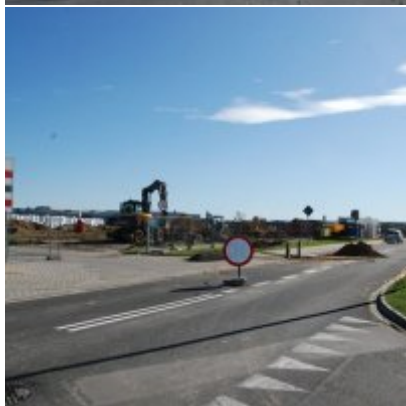
Fotogaleria Zatorskiej Strefy Aktywności Gospodarczej
