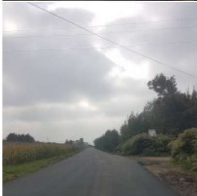
Praca wre - modernizacja drogi wojewódzkiej.
