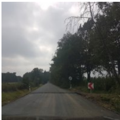
Praca wre - modernizacja drogi wojewódzkiej.
