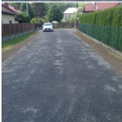
Modernizacja ul. Grunwaldzkiej
