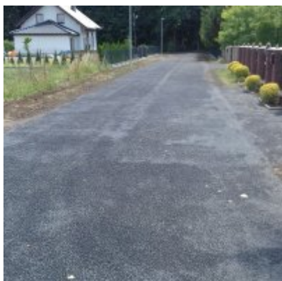
Modernizacja ul. Grunwaldzkiej
