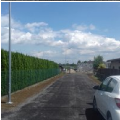
Modernizacja ul. Grunwaldzkiej
