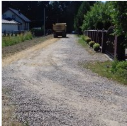
Rozpoczęto prace modernizacyjne na ul. Grunwaldzkiej
