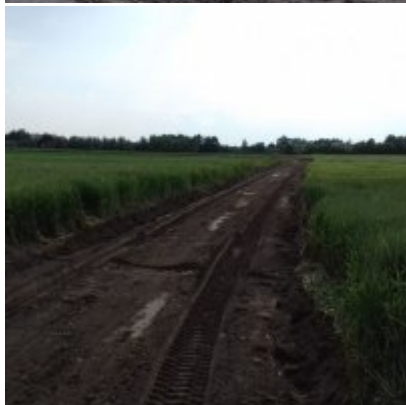
Modernizacja drogi wewnętrznej
