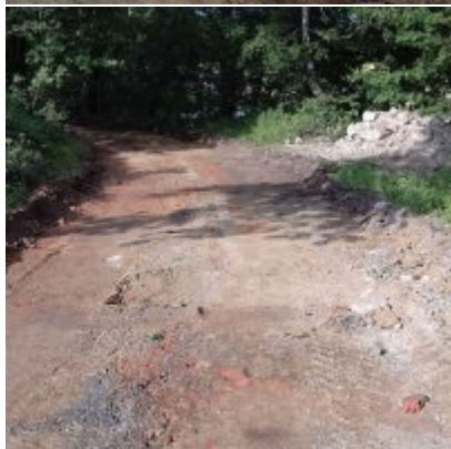
Modernizacja drogi wewnętrznej
