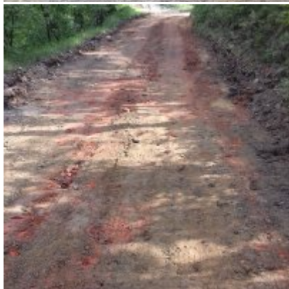
Modernizacja drogi wewnętrznej
