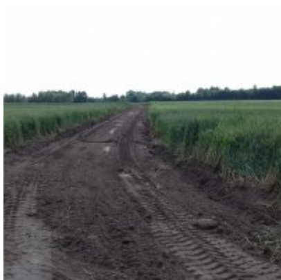
Modernizacja drogi wewnętrznej
