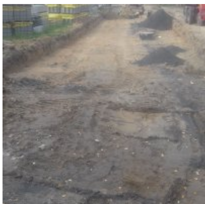
Prace budowlane na Al. Chopina w Zatorze
