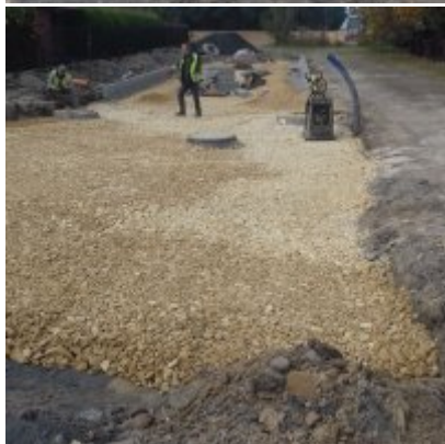
Prace budowlane na Al. Chopina w Zatorze
