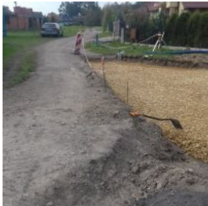
Prace budowlane na Al. Chopina w Zatorze
