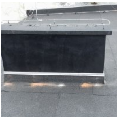
Remont dachu Szkoły podstawowej w Laskowej
