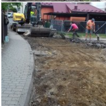
Remont ulicy Szkolnej w Zatorze
