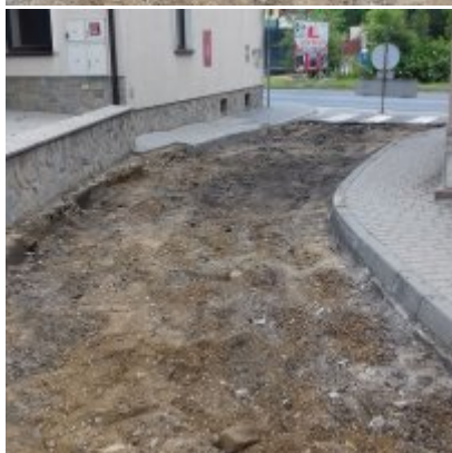
Remont ulicy Szkolnej w Zatorze
