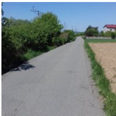
Rozpoczęcie robót remontowych
