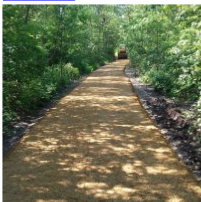
Utworzenie szlaku rowerowego od zamku w Zatorze do zamku w Graboszycach w Gminie Zator, w ramach Programu Operacyjnego Rybactwo i Morze. Wartość robót 339.099,33 zł. Termin wykonania – najpóźniej do 30.05.2018 r.
