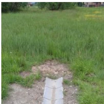
Rozpoczęcie robót dróg
