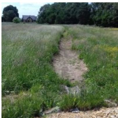
Rozpoczęcie robót dróg
