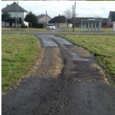
Rozpoczęcie robót dróg
