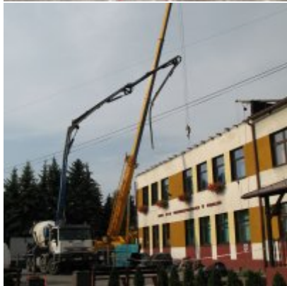
Remont dachu w ZSO Podolsze
