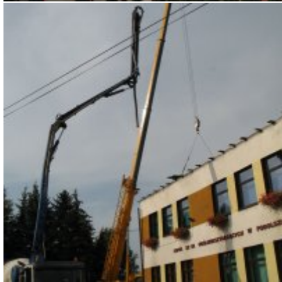
Remont dachu w ZSO Podolsze
