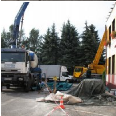
Remont dachu w ZSO Podolsze
