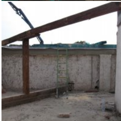
Remont dachu w ZSO Podolsze
