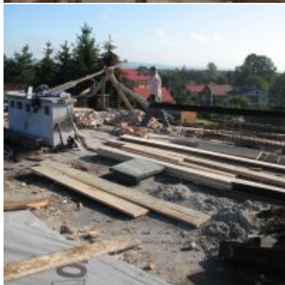
Remont dachu w ZSO Podolsze
