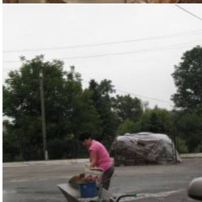
Remont dachu w ZSO Podolsze
