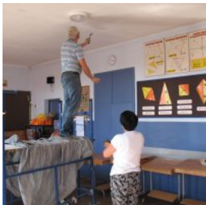
Remont dachu w ZSO Podolsze
