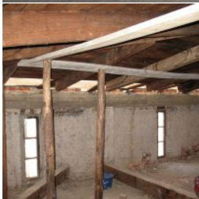
Remont dachu w ZSO Podolsze
