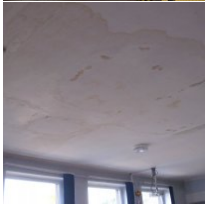
Remont dachu w ZSO Podolsze
