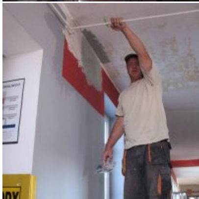
Remont dachu w ZSO Podolsze
