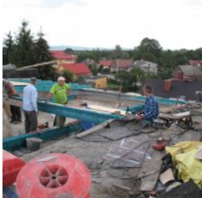
Remont dachu w ZSO Podolsze
