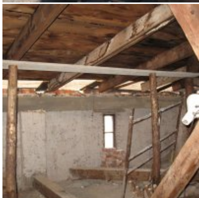
Remont dachu w ZSO Podolsze
