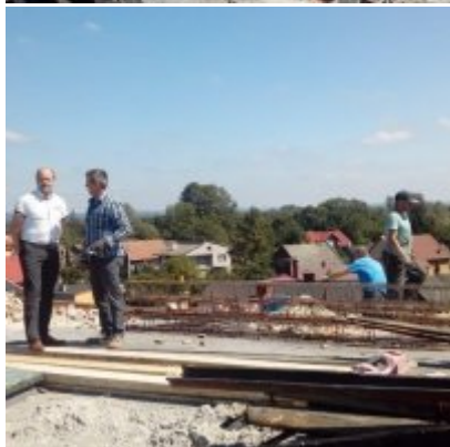
MODERNIZACJA DACHU NA BUDYNKU ZSO w PODOLSZU
