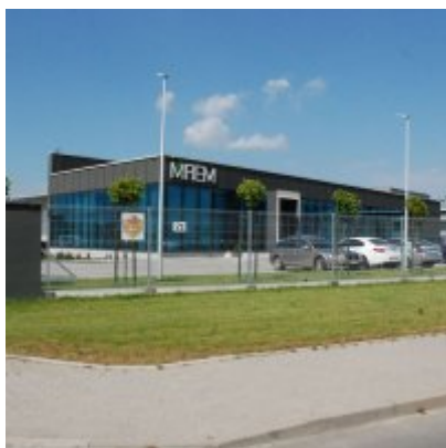
Zatorska Strefa Aktywności Gospodarczej FOTOGALERIA - czerwiec 2017
