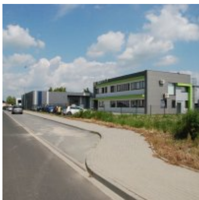
Zatorska Strefa Aktywności Gospodarczej FOTOGALERIA - czerwiec 2017
