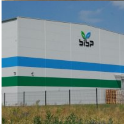
Zatorska Strefa Aktywności Gospodarczej FOTOGALERIA - czerwiec 2017
