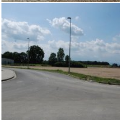
Zatorska Strefa Aktywności Gospodarczej FOTOGALERIA - czerwiec 2017
