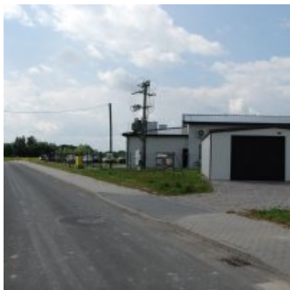
Zatorska Strefa Aktywności Gospodarczej FOTOGALERIA - czerwiec 2017
