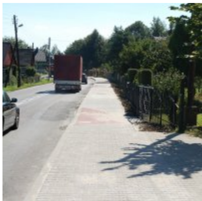
Wyremontowany chodnik w Podolszu
