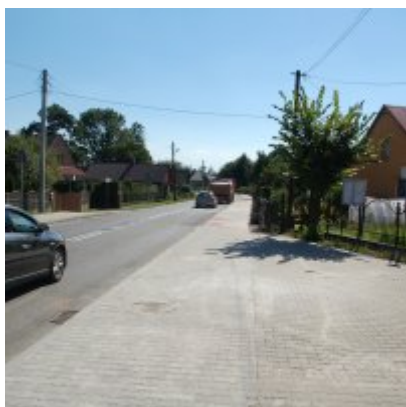
Wyremontowany chodnik w Podolszu
