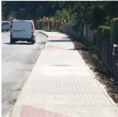
Wyremontowany chodnik w Podolszu
