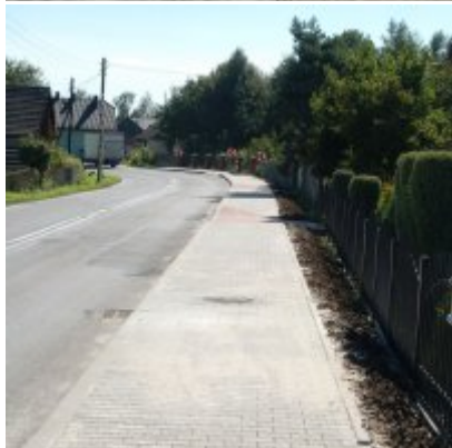
Wyremontowany chodnik w Podolszu
