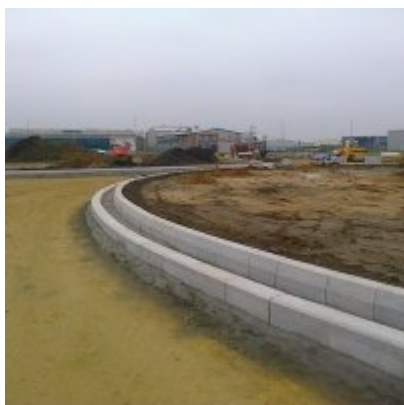
2016-04-13 Bieżący stan prac przy budowie ronda.
