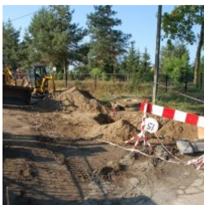
Budowa odwodnienia ul. Gimnazjalnej w Podolszu
