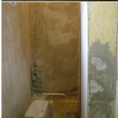
Przebudowa i modernizacja remizy strażackiej w Zatorze
