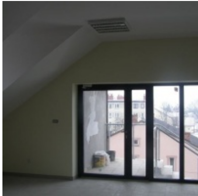
Przebudowa i modernizacja remizy strażackiej w Zatorze
