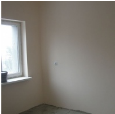
Przebudowa i modernizacja remizy strażackiej w Zatorze
