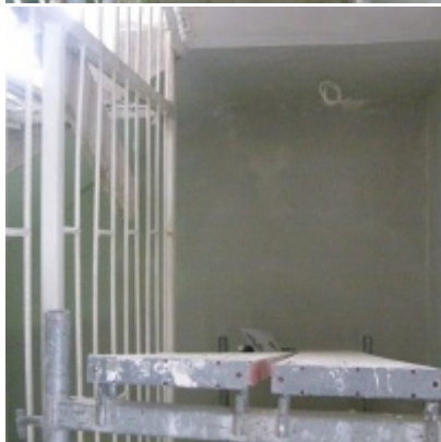
Przebudowa i modernizacja remizy strażackiej w Zatorze
