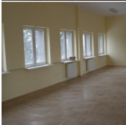
Przebudowa i modernizacja remizy strażackiej w Zatorze
