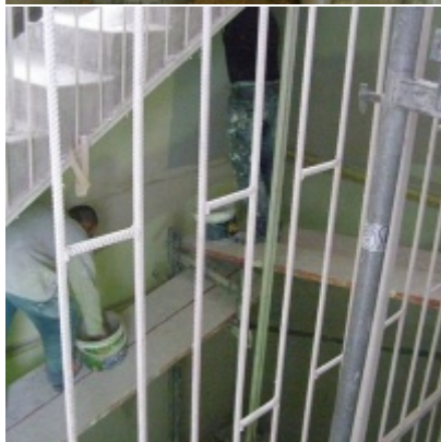
Przebudowa i modernizacja remizy strażackiej w Zatorze
