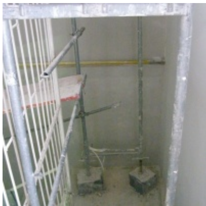
Przebudowa i modernizacja remizy strażackiej w Zatorze
