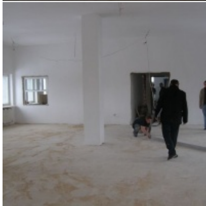
Przebudowa i modernizacja remizy strażackiej w Zatorze
