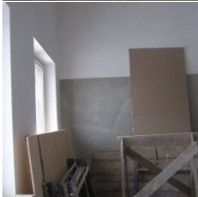
Przebudowa i modernizacja remizy strażackiej w Zatorze
