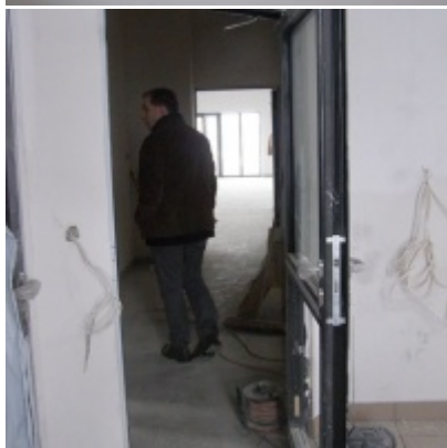
Przebudowa i modernizacja remizy strażackiej w Zatorze
