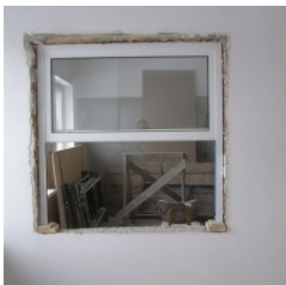
Przebudowa i modernizacja remizy strażackiej w Zatorze
