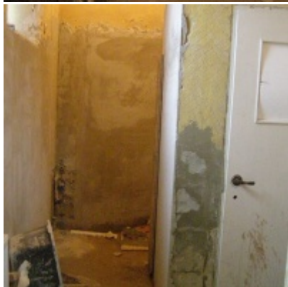
Przebudowa i modernizacja remizy strażackiej w Zatorze
