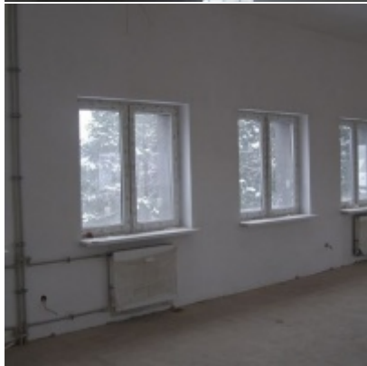
Przebudowa i modernizacja remizy strażackiej w Zatorze
