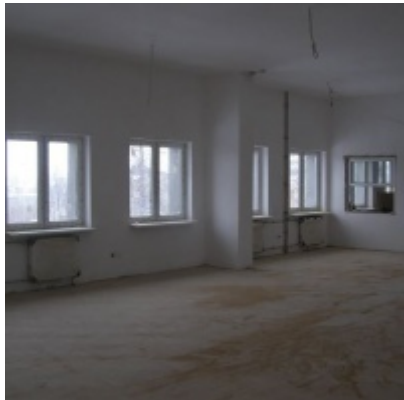
Przebudowa i modernizacja remizy strażackiej w Zatorze
