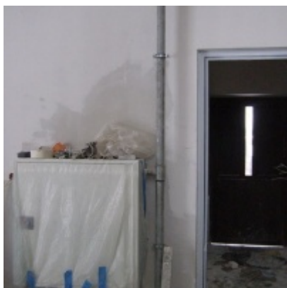
Przebudowa i modernizacja remizy strażackiej w Zatorze
