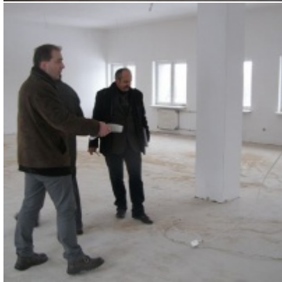
Przebudowa i modernizacja remizy strażackiej w Zatorze
