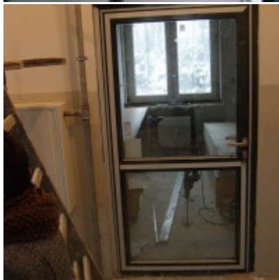
Przebudowa i modernizacja remizy strażackiej w Zatorze
