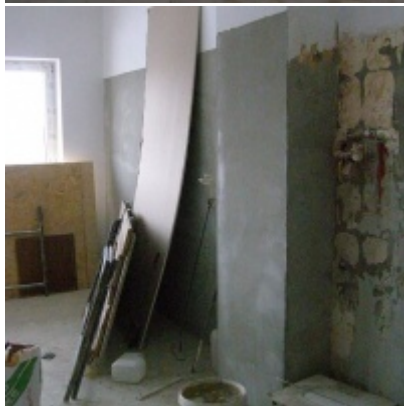
Przebudowa i modernizacja remizy strażackiej w Zatorze
