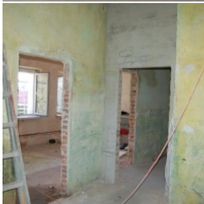
Przebudowa i modernizacja remizy strażackiej w Zatorze
