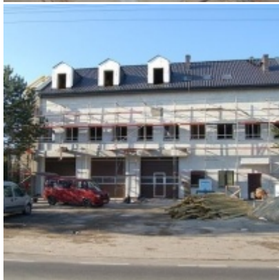
Przebudowa i modernizacja remizy strażackiej w Zatorze
