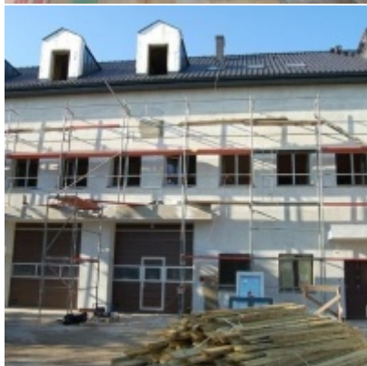
Przebudowa i modernizacja remizy strażackiej w Zatorze
