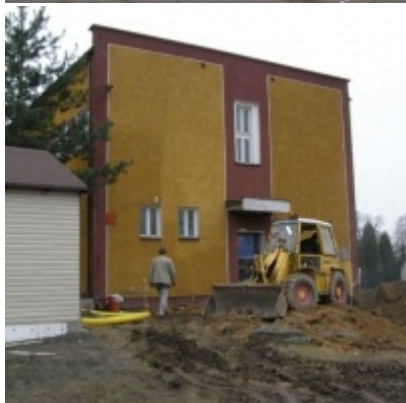
Przebudowa i modernizacja remizy strażackiej w Zatorze
