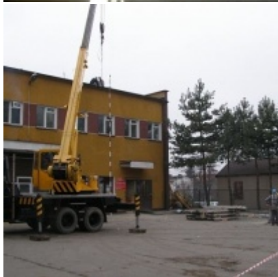
Przebudowa i modernizacja remizy strażackiej w Zatorze
