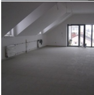
Przebudowa i modernizacja remizy strażackiej w Zatorze
