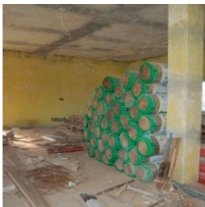
Przebudowa i modernizacja remizy strażackiej w Zatorze
