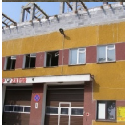
Przebudowa i modernizacja remizy strażackiej w Zatorze
